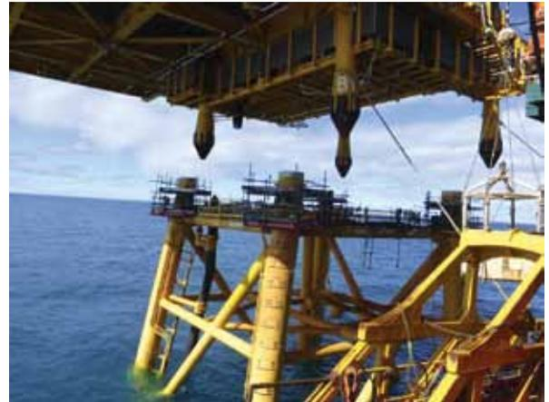
El desarrollo de Vega Pléyade consistió en la construcción e instalación de una plataforma en el mar, en una zona con una profundidad de agua de 50 m, que se conecta a través de un gasoducto submarino de 77 km a las plantas de tratamiento de gas de Río Cullen y Cañadon Alfa también operadas por Total.
