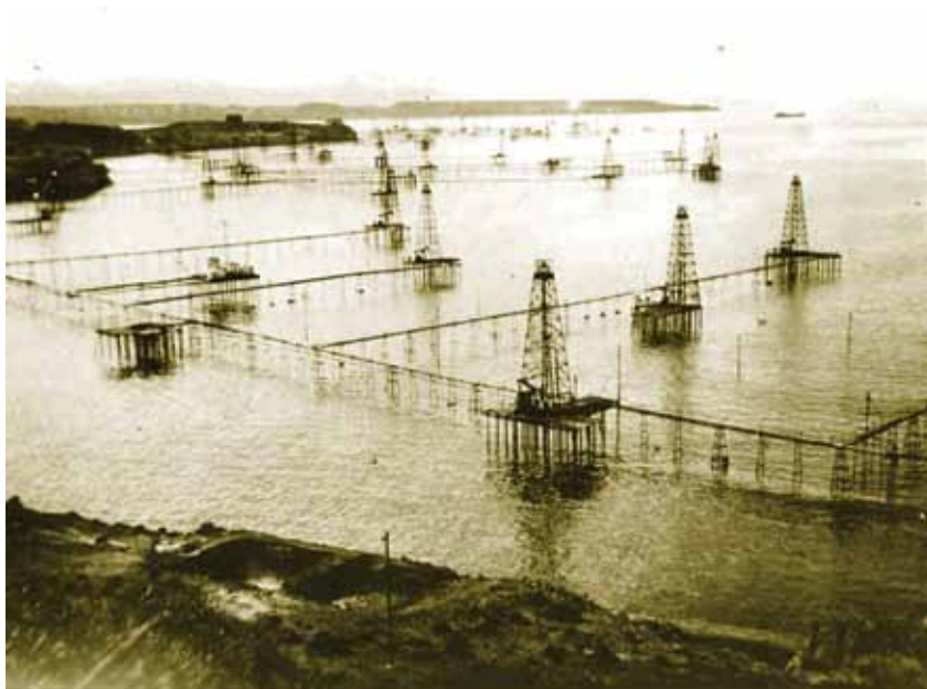
Pozos con pasarelas en Caleta Córdova.
