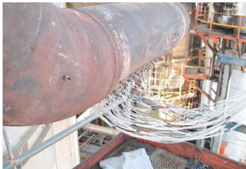
Figura 5. (Instalación en Refinería Luján de Cuyo. Cortesía de Fox Tek y Baker Hughes).
