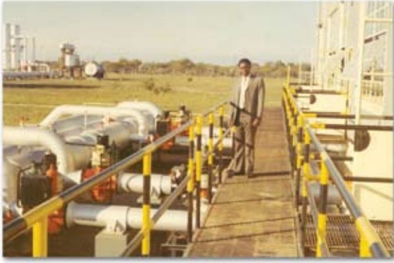
Planta compresora Lavalle
