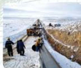
Proyecto de Ampliación de la Capacidad de Transporte Firme de Gas Argentina
