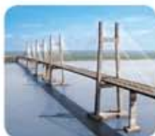
Segundo Puente sobre el Río Orinoco Venezuela
