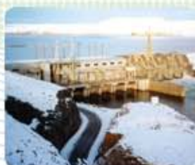
Hidroeléctrica Pichi Picún Leufú Argentina
