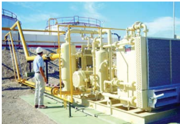
Figura 7. URV instalada en batería de tanques
