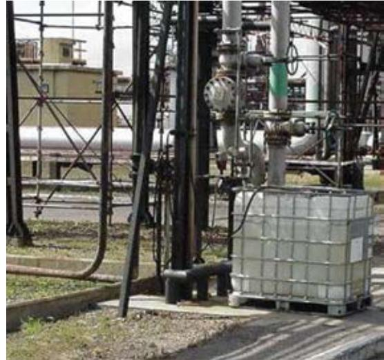
El agua puede no humedecer correctamente el carbón, por esa razón se le dosifica automáticamente un producto surfactante que baja la tensión superficial del agua y asegura el correcto humedecimiento y la penetración del agua en la superficie del carbón.
