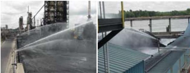
Inyección de surfactante en agua de regado de pila de carbón (2001).
