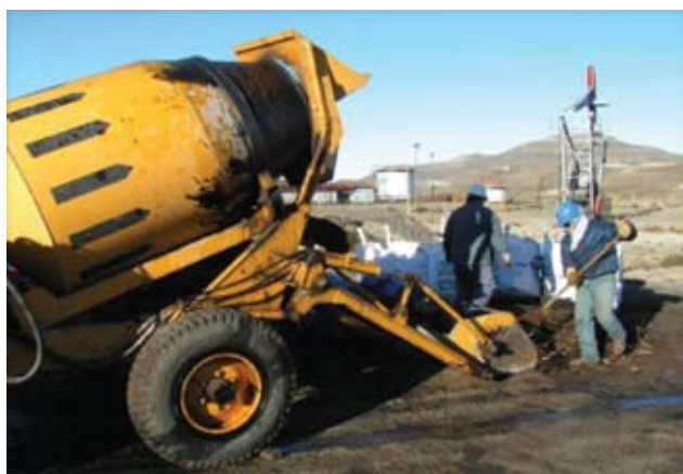
Hormigonera donde se realizó el lavado en caliente y con detergente biodegradable del material triturado con presencia de hidrocarburo.
