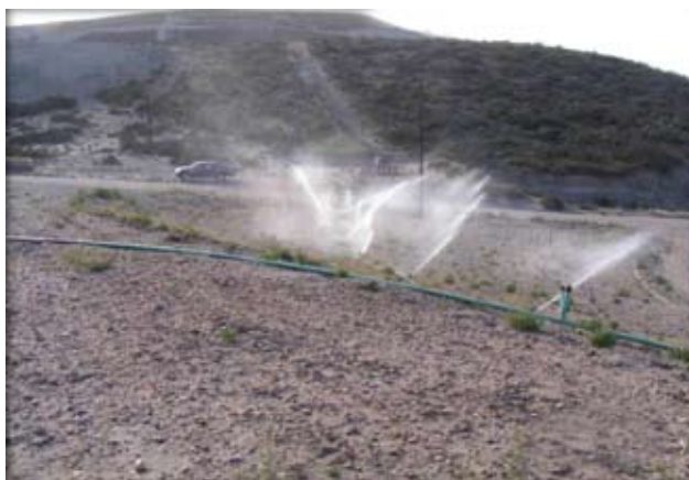
Sistema de riego por aspersión instalado.
