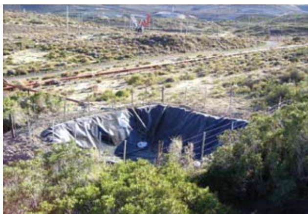
Vista de una de las piletas de contención secundaria construidas.
