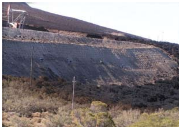
Tareas de conformación de microrelieves y plantación de ejemplares arbustivos autóctonos.
