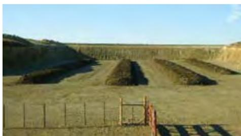
Se construyeron 4 biopilas hasta totalizar un volumen aproximado –de acuerdo con el esponjamiento inicial– de 1.100 m<sup>3</sup>. A los efectos de mantener la oxigenación y los valores de humedad óptimos para el proceso y el desarrollo de los microorganismos activos, se procedió al riego con inóculo bacteriano de las biopilas, con frecuencia semanal.
