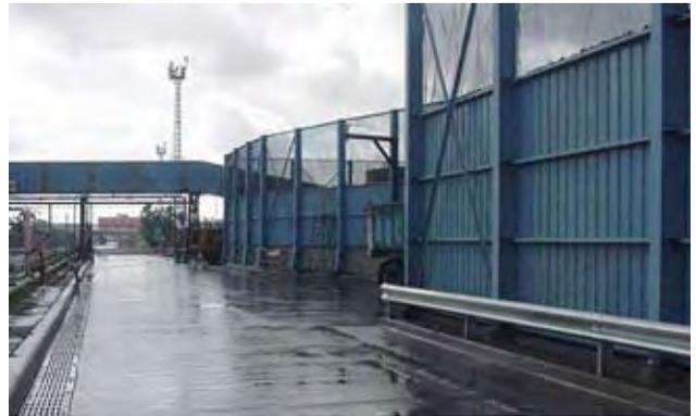
con anemómetro dentro y fuera de la pila mostraron una reducción en la velocidad del viento del orden del 90%.
