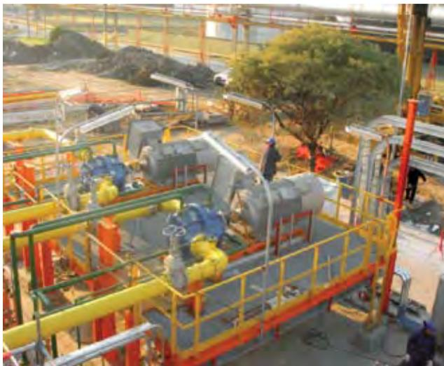
Figura 3. Zona de Compresión I: Se instalaron dos compresores.
