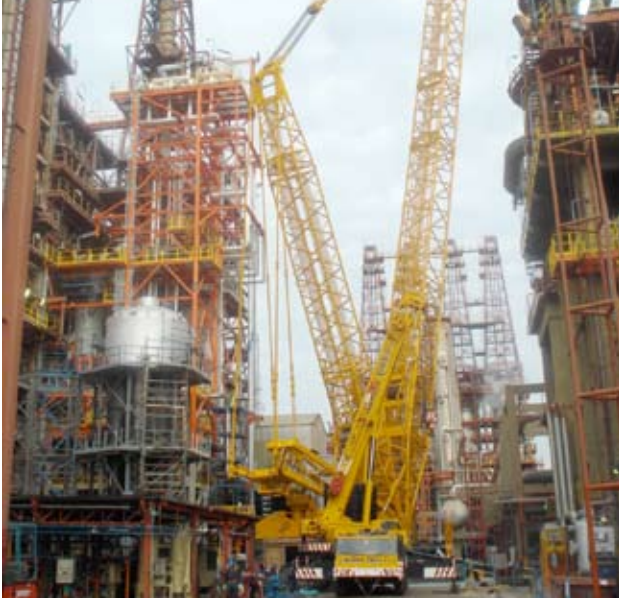
Figura 12. La grúa en trabajo
