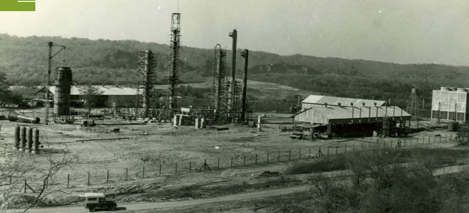
Vista de la Planta de YPF a fines de los años '30
