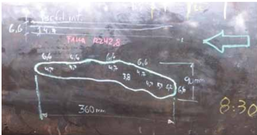
Figura 2. Laminación no paralela en tramo 1 abierta hacia adentro.
