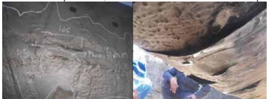
Figura 1. Corrosión externa debido al apantallamiento de revestimientos de cintas.
