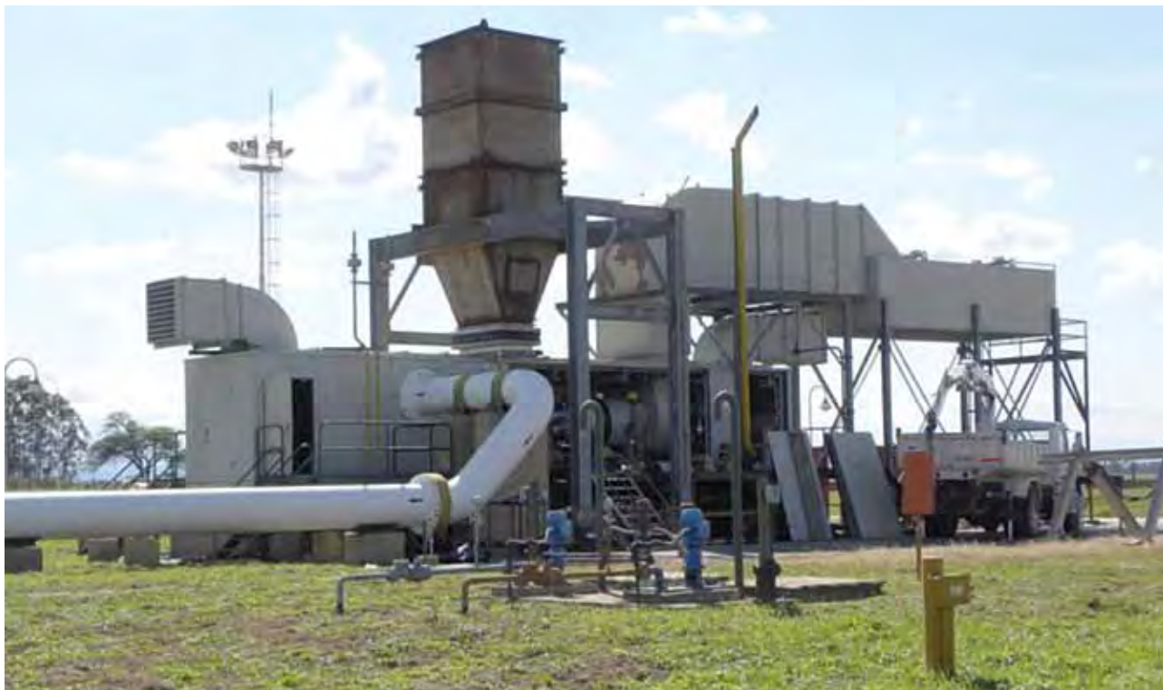
Planta compresora Pichanal.
