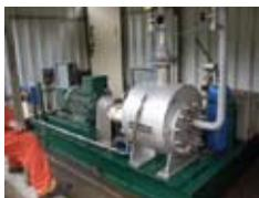
Las bombas multifase pueden ser utilizadas en cualquier punto del ducto para incrementar la presión del flujo multifase proveniente directamente del pozo. Cuando sólo se requiere un *boosting* para ciertas aplicaciones, esto no sólo resultará en un beneficio por una mayor presión de descarga, sino que puede ser una buena forma de remover depósitos como ceras y parafinas ya existentes y formados en el ducto.
