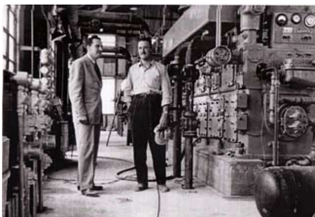
El autor (der.) con el ingeniero H. Virgen, de la empresa Clark, en la planta compresora de Gas de Chelforó (Río Negro), febrero de 1957
