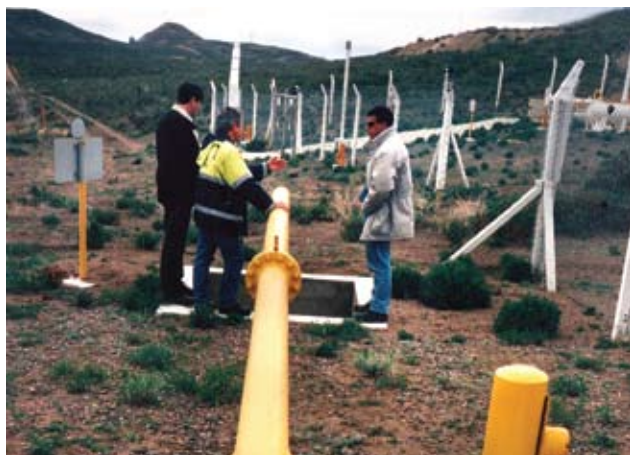
Complejo Neuquén. Cambio de traza al Gasoducto D24
