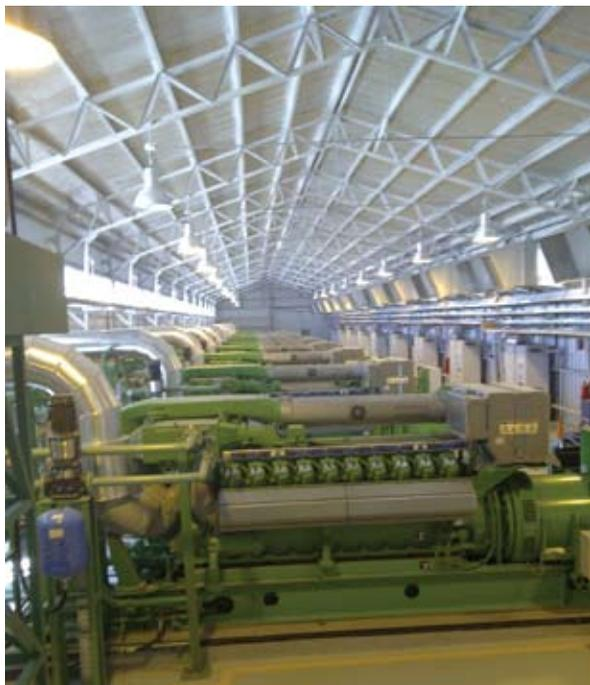
En efecto, Medanito ha sumado la producción de electricidad a la de petróleo (250 m<sup>3</sup>/d) y gas (un millón de m<sup>3</sup>/d), así como de LPG (5.000 t/mes) que viene incrementado desde hace años. La nueva central tiene una potencia instalada de 25 MW con alto rendimiento y está acoplada a una EETT de 132 kW construida para posibilitar el transporte en alta tensión. Con esto se completa una inversión de 35 millones de dólares.
