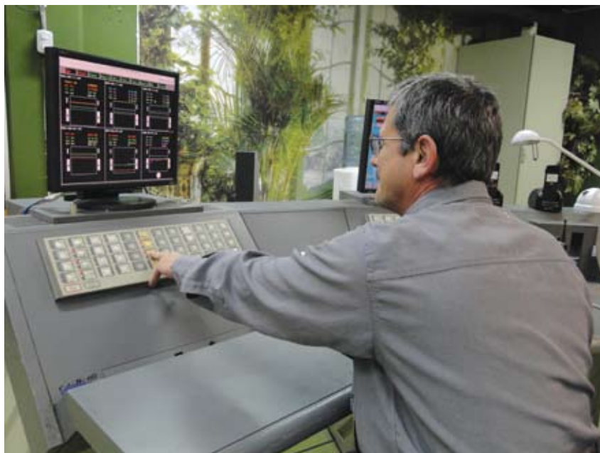
Figura 1. Sala de control donde se observan paneles cableados e interfaces modernas
