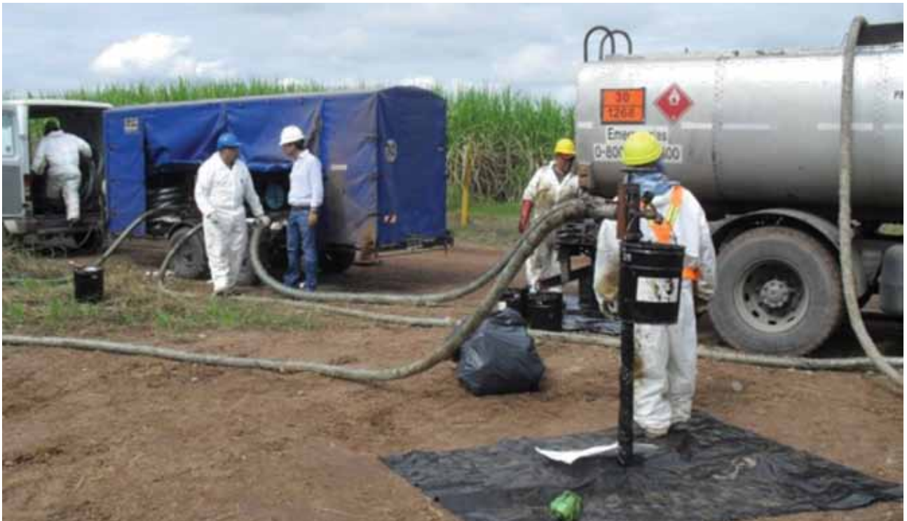
Foto 5. Inyección de la cera microcristalina.
