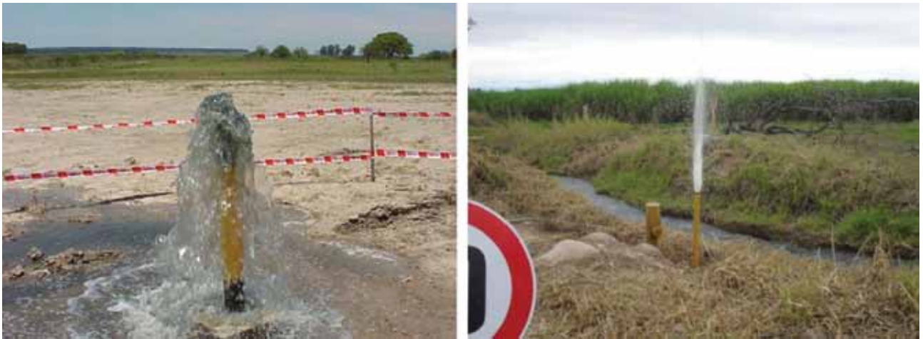
Fotos 1 y 2. Verificación de circulación de aire y eliminación del agua en el interior del caño camisa.
