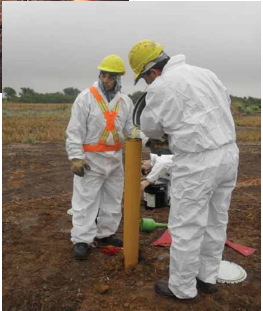
Foto 4. Vertido del líquido inhibidor de corrosión y bactericida.
