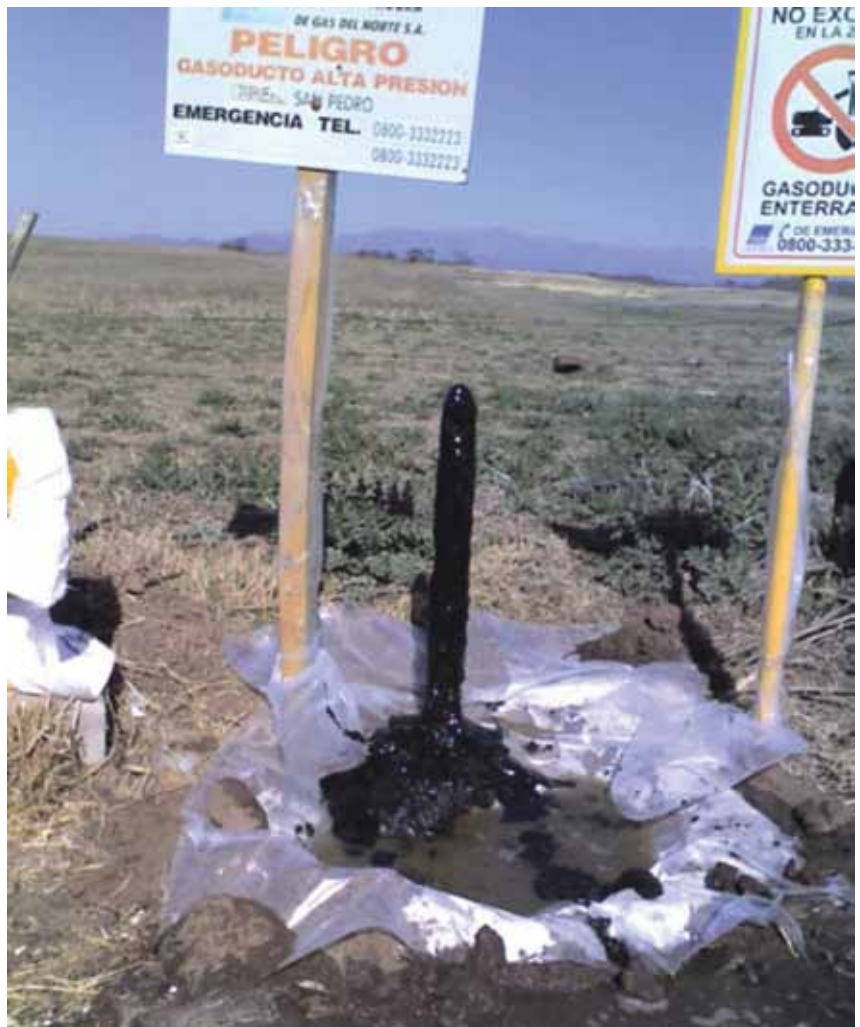
Foto 6. Etapa final del llenado con cera microcristalina.
