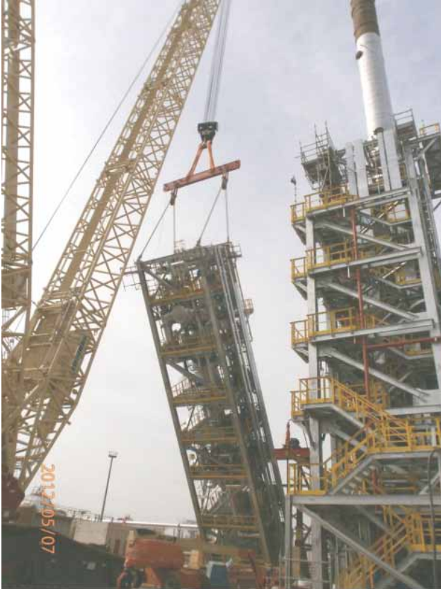
Figura 4. Módulos de la unidad CCR siendo izado para su montaje - Gentileza Odebrecht.
