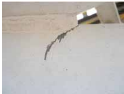
Foto 3. Fisura diagonal derecha.
