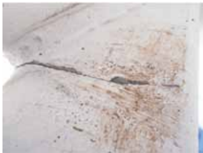
Foto 1. Fisura diagonal izquierda.
