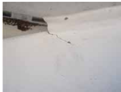
Foto 4. Fisura diagonal derecha.
