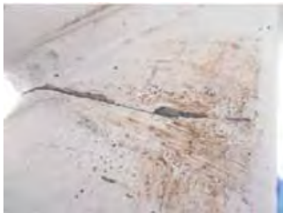
Foto 1. Fisura diagonal izquierda.
