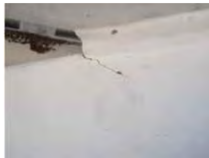
Foto 4. Fisura diagonal derecha.
