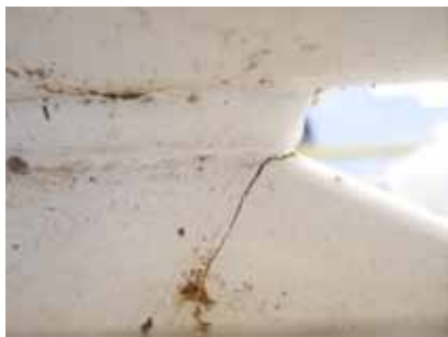
Foto 2. Fisura diagonal izquierda.
