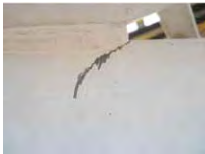
Foto 3. Fisura diagonal derecha.
