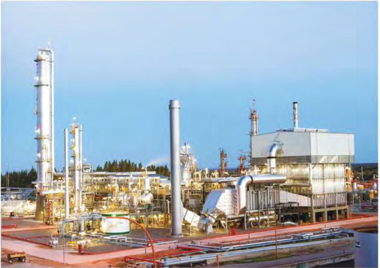
Planta productora de metanol y unidades de proceso en la refinería de YPF en Plaza Huincul, Neuquén, Argentina.
