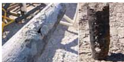
Figura 1. Daño por corrosión en casings. Izquierda, extraído durante reparaciones con casing patch . Derecha, zona de punzado extraída durante intervención.
