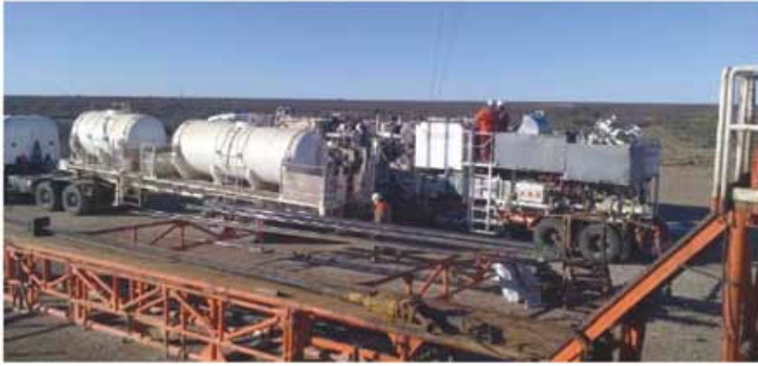
Figura 7. Equipamiento empleado para el bombeo del sistema casing líquido con equipo de WO.
