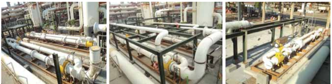
Figura 10b. Patín de regulación (PR-200) y 3 patines de medición (PM-200) en la refinería.
