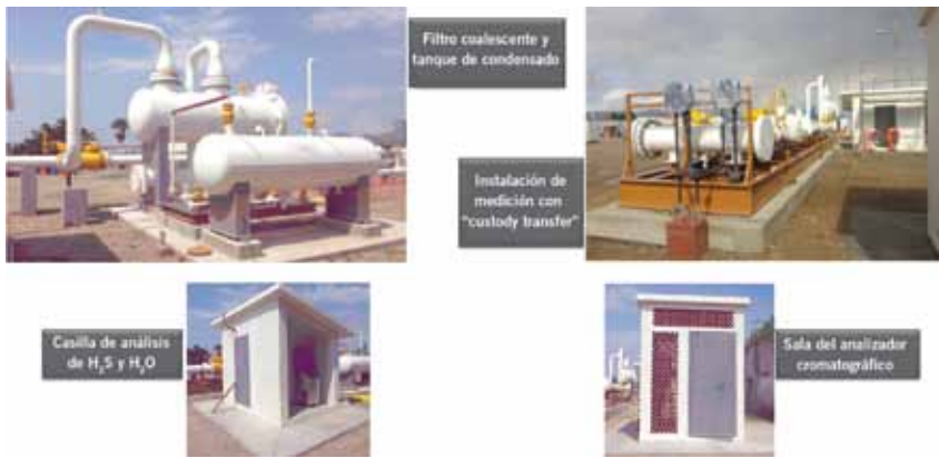
Figura 7a. Instalaciones de medición de flujo.
