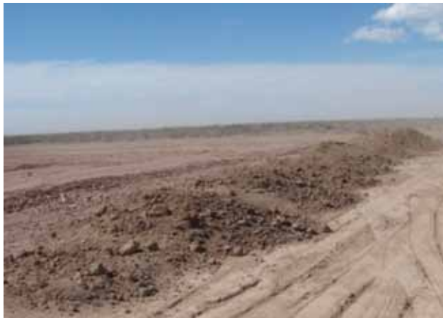
Figura 6. Colocación de la mezcla en la locación.
