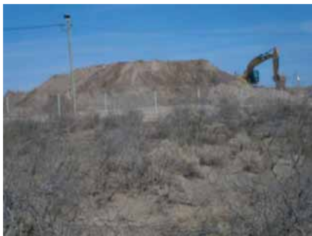
Figura 3. Remoción de recortes del recinto de acopio.
