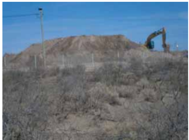
Figura 3. Remoción de recortes del recinto de acopio.
