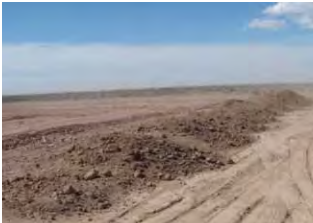
Figura 6. Colocación de la mezcla en la locación.
