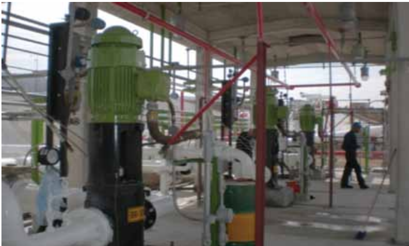
Figura 4. Sala de bombas.
