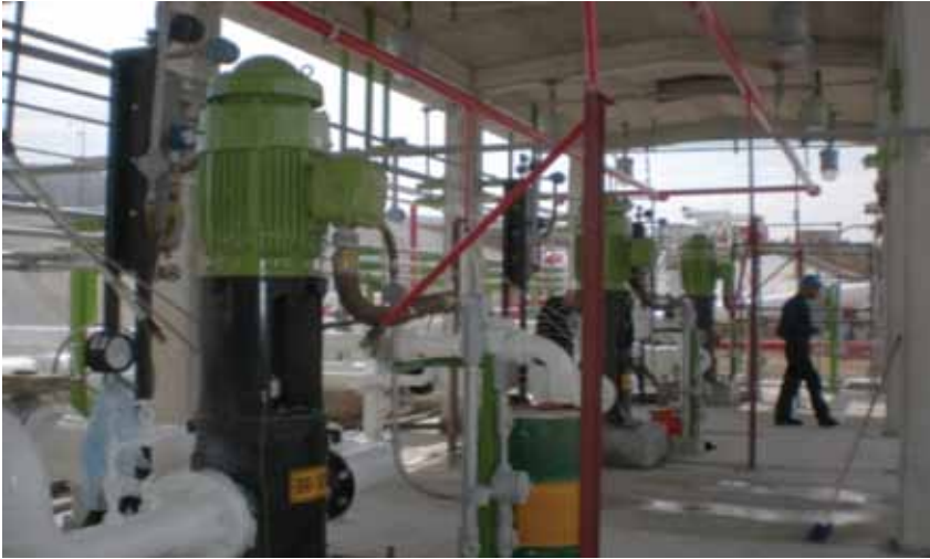
Figura 4. Sala de bombas.
