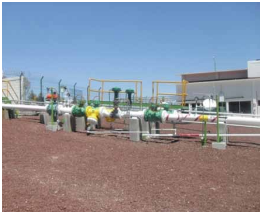
Figura 3. Recepción de Gas L.P. del gasoducto Cactus – Zapopan – Tula – Estación EB-04.
