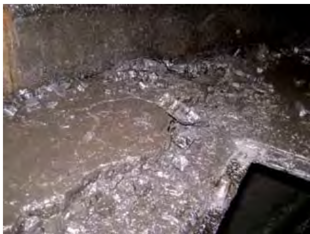
Figura 4. Vista del plato de la zona de lavado que muestra el espesor de los depósitos, agosto del 2011.
