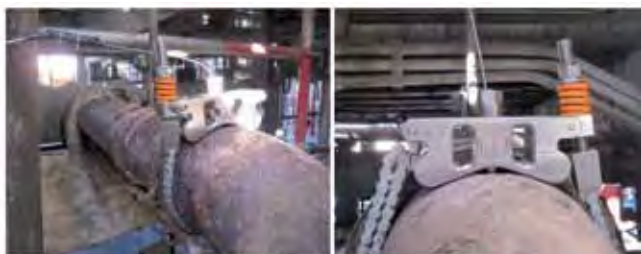
Sensor fijo de monitoreo de corrosión instalado en una cañería.
