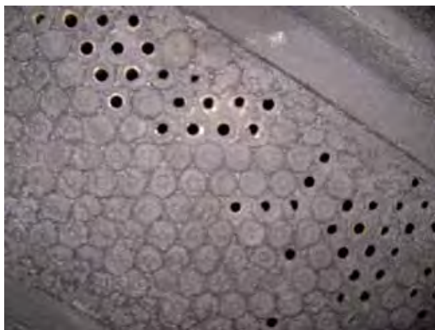
Figura 5. Vista inferior del plato de la zona de lavado que muestra agujeros tapados, agosto del 2011.
