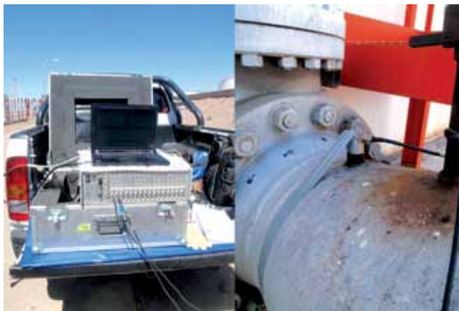
Control de cañería enterrada de salida de pie de tanque.
