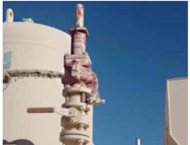
Figura 7. Válvula de bloqueo sin candado.
