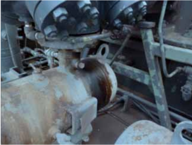
Figura 4. Fuga de proceso.
