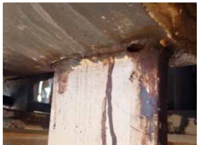
Figura 9. Fisura en soldadura.
