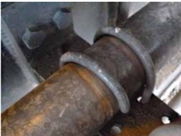
Figura 8. Desgaste por vibraciones.
