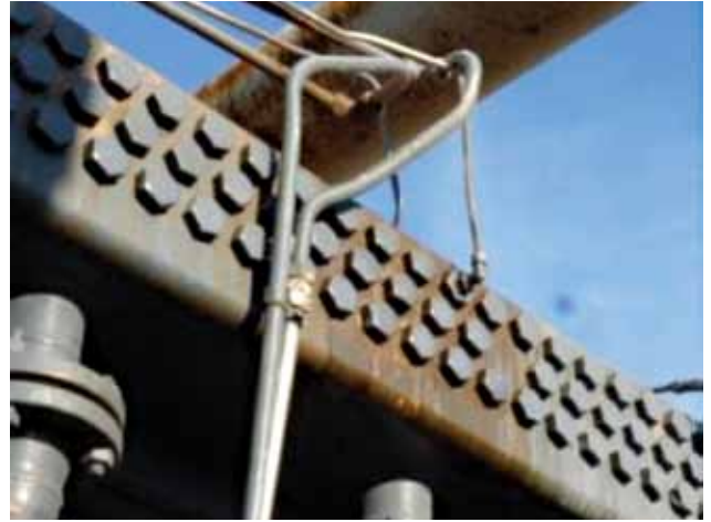
Figura 5. Fuga de proceso.
