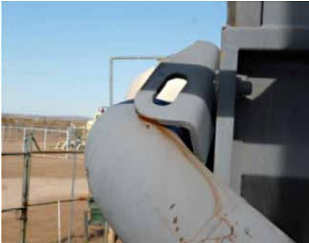
Figura 6. Desgaste por contacto y rozamiento.
