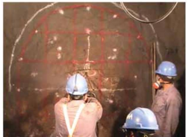
Figura 11. Operarios realizando los primeros taladros de arranque sobre la malla de perforación confeccionada sobre el frente de voladura.
