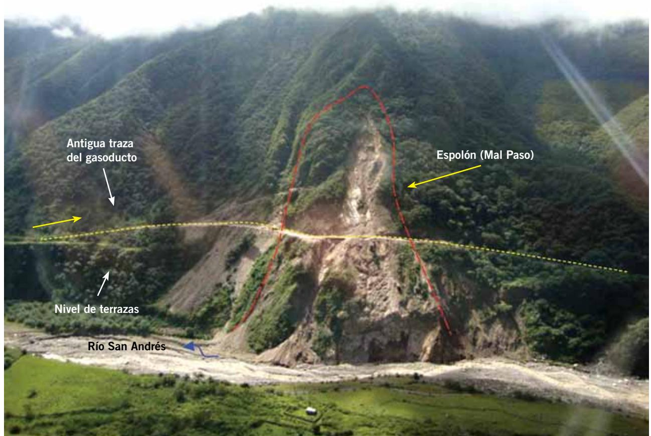
Figura 3. Macizo de Mal Paso. Característica del sector donde los bloques de roca interrumpen el nivel de terrazas del Río San Andrés. La línea amarilla representa la antigua traza por donde transitaba el gasoducto, ahora reemplazada por el túnel. La roca predominante que se observa en colores claros corresponde a cuarcitas blanquecinas compactas. La línea de trazos roja indica aproximadamente la zona con potencial deslizamiento.
