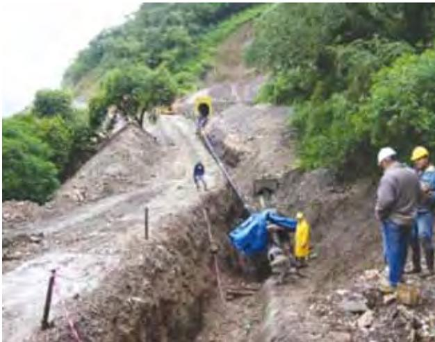
Figura 19. Ensamblado de la cañería a la línea en el portal sur.
