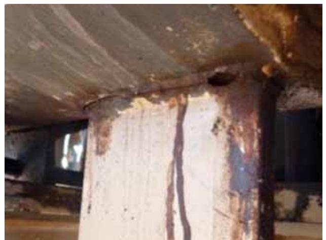
Figura 9. Fisura en soldadura.
