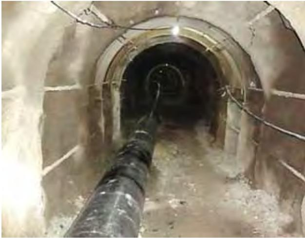
Figura 17. Tubería ya colocada en su posición final en interior del túnel, vista desde el portal sur. Obsérvese la curvatura final de la misma por flexión natural en el fondo de la fotografía.
