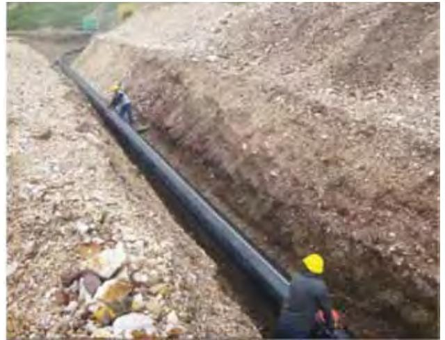
Figura 18. Ensamblado de la cañería a la línea en el portal norte.
