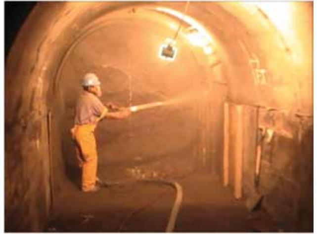
Figura 13. Operario colocando shotcrete en zonas inestables.
