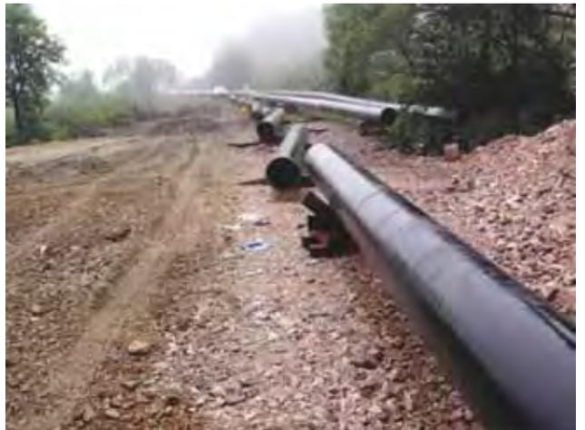
Figura 15. Preparación de las columnas de tuberías para su posterior colocación.
