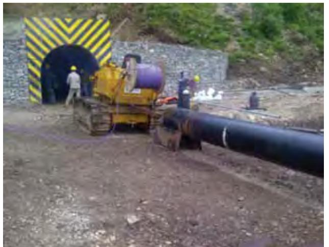
Figura 16. Inicio de la colocación del encolumnado por el portal norte.
