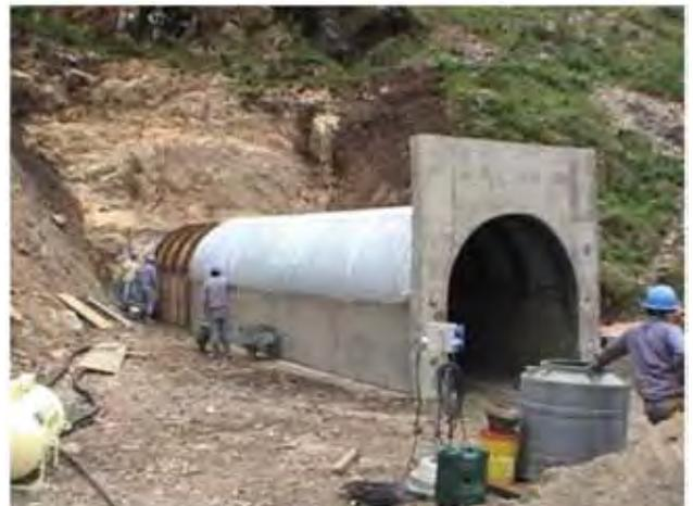
Figura 10. Armado del falso túnel del portal norte.
