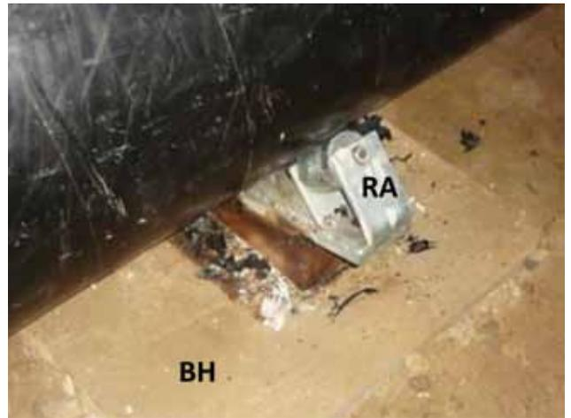
Figura 14. Soporte completo con base de hormigón (BH) y rodillo de acero amurado (RA).
