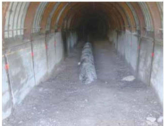
Figura 20. Tapada final y enterramiento de la cañería a la salida del portal sur.
