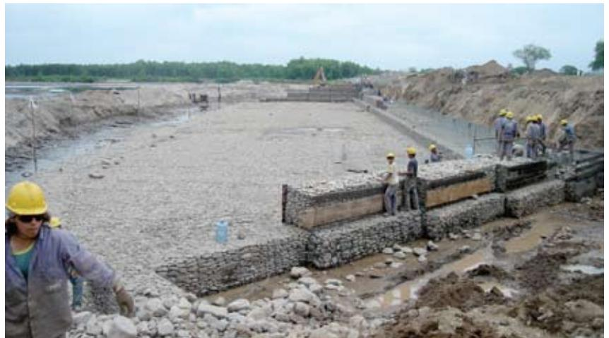
Figura 38. Muro de gaviones y espigones de transición
