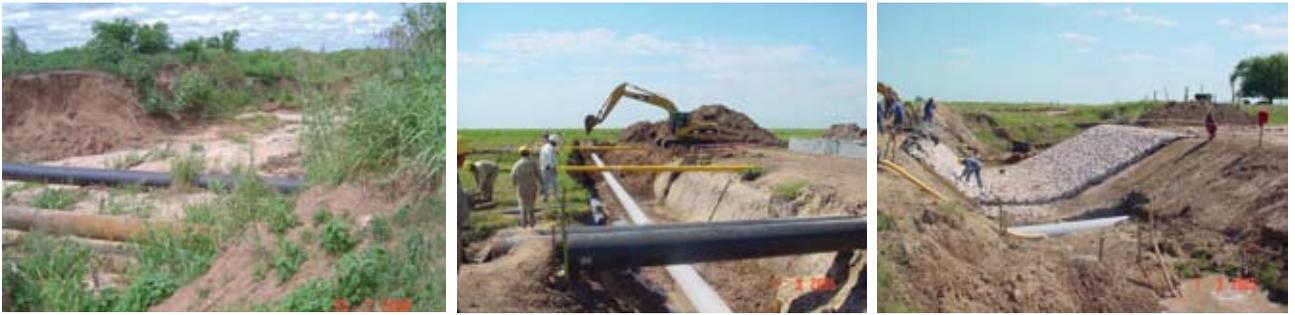
Figuras 2 a 4. Cañerías expuestas, protección superficial después del descenso
