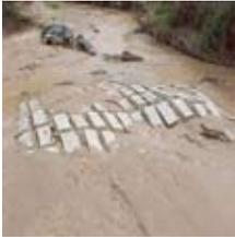
Figura 24. Mantas con bloques deformados
