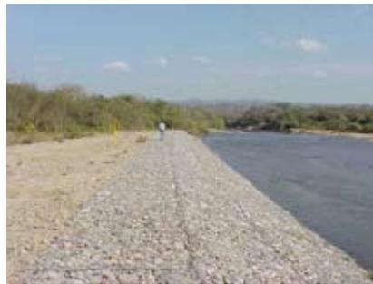
Figura 36. Protección de margen con colchonetas
