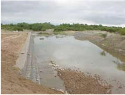
Figura 39. Muros de gaviones en ambas márgenes
