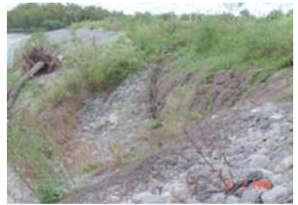
Figura 37. Derrumbe por erosión al pie
