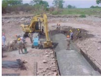
Figura 25. Coraza de hormigón
