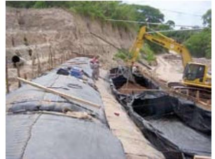
Figura 42. Relleno y cierre de geotubos
