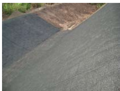
Figura 27. Revestimiento de TRM
