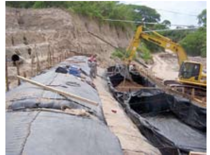
Figura 42. Relleno y cierre de geotubos
