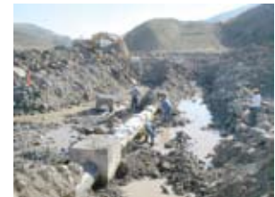
Figura 45. Colocación de contrapesos
