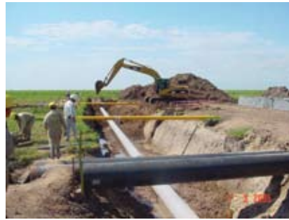
Figuras 2 a 4. Cañerías expuestas, protección superficial después del descenso
