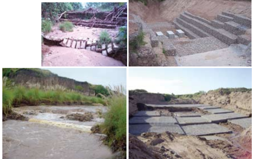
Figuras 12 a 15. Ejemplos de cuencos disipadores
