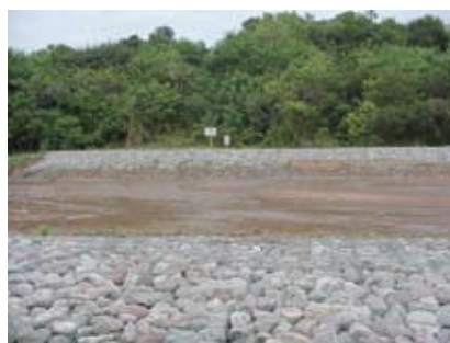
Figuras 21 y 22. Ejemplos de colchonetas antes y después de su colocación
