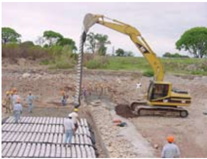
Figura 23. Colocación de mantas
