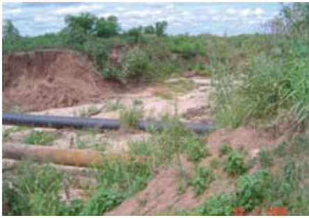
Figuras 2 a 4. Cañerías expuestas, protección superficial después del descenso
