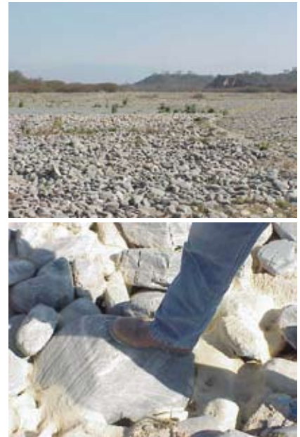
Figuras 17 y 18. Ejemplos de revestimientos de escollera
