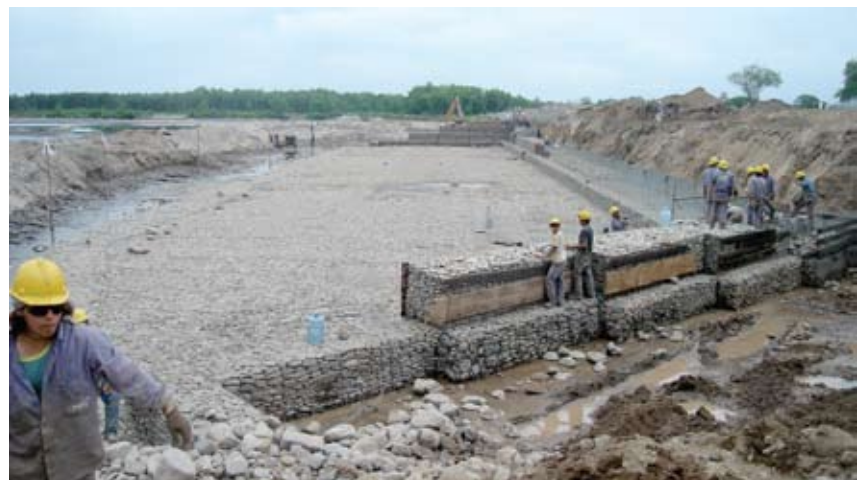
Figura 38. Muro de gaviones y espigones de transición
