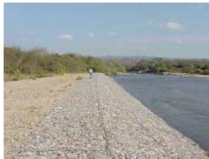
Figura 36. Protección de margen con colchonetas
