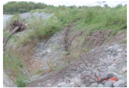
Figura 37. Derrumbe por erosión al pie
