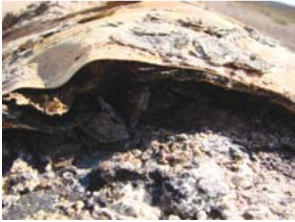
Figura 8. Celda de corrosión debajo del revestimiento despegado
