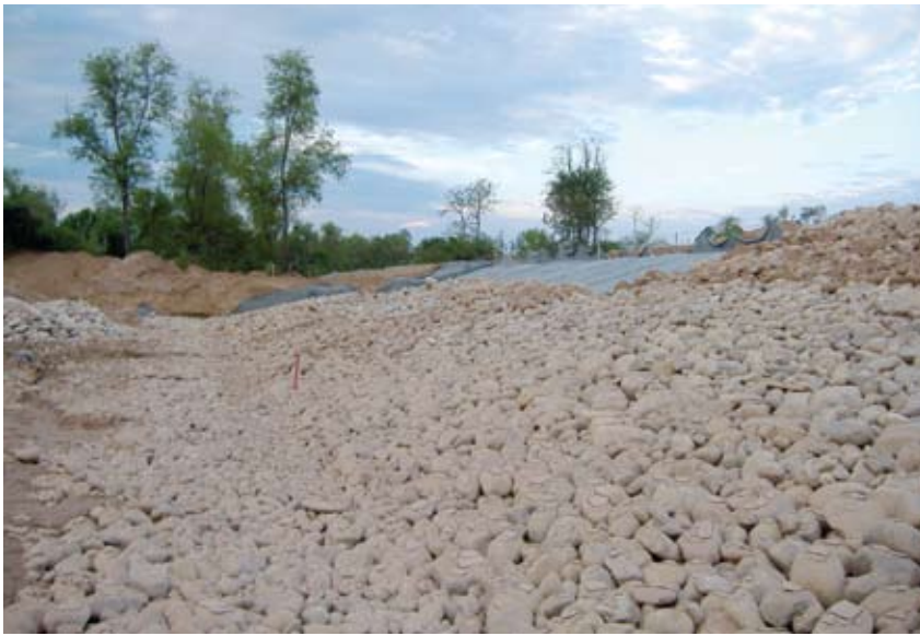
Figura 34. Protección de margen
