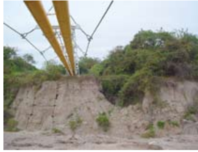
Figura 10. Cruce aéreo de 110 m de luz
