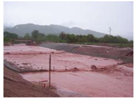
Figura 26. Obra en funcionamiento
