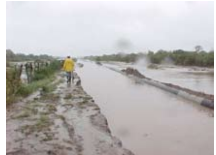
Figura 44. Tubería flotando
