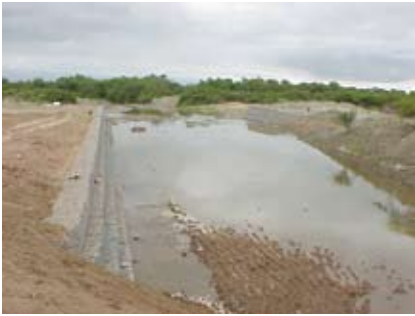
Figura 39. Muros de gaviones en ambas márgenes
