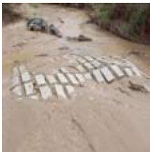
Figura 24. Mantas con bloques deformados
