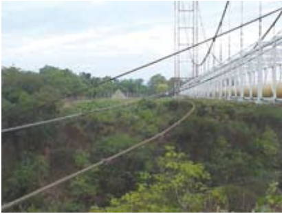
Figura 9. Cruce aéreo de 200 m de luz
