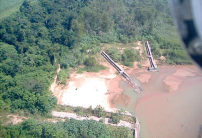
Figura 40. Espigones de gaviones
