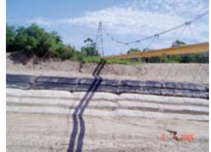
Figura 43. Obra terminada con gunitadobos
