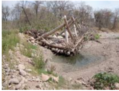
Figura 41. Espigones tipo "patas de gallo"
