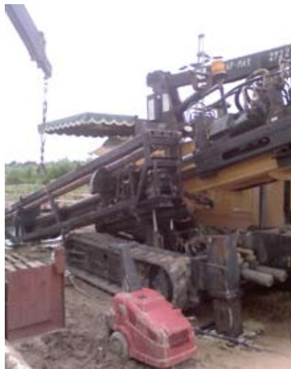
Figuras 5 y 6. Máquina perforadora y pileta de lodos bentoníticos
