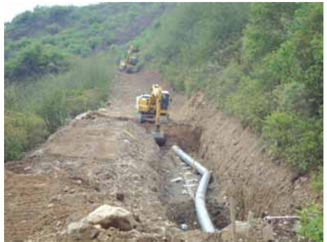
Figura 7. Deformación brusca de la cañería a los primeros 27 m en la zona topográficamente más baja del talud.
