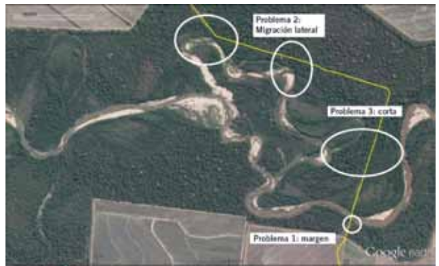
Figura 2. Cruce del Río Santa María. Cruce construido con una traza tangente a los meandros.
