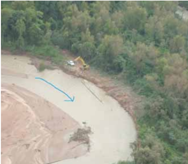
Figura 18. Destape del gasoducto aguas arriba del cruce.
