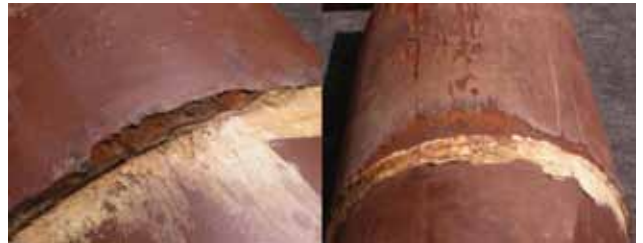
Figura 14. Desprendimiento de coating y corrosión con pérdida de material sobre el borde de junta 3B. Puede apreciarse la resina que recubre el borde y se presume posterior al embonado de los caños.
