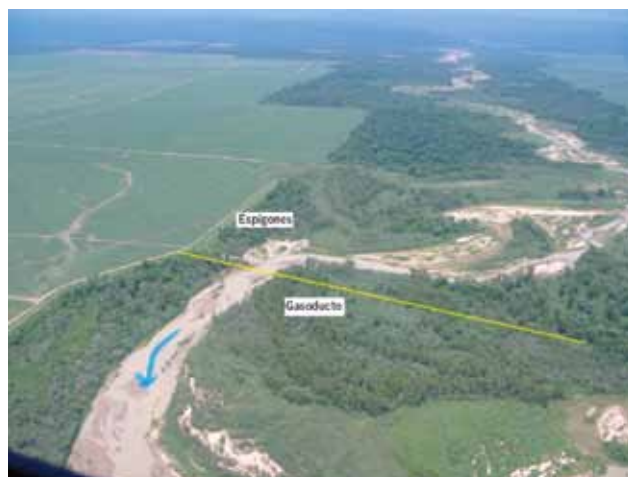
Figura 16. Protección del cuello de cisne mediante espigones que reconstituyen la margen erosionada.
