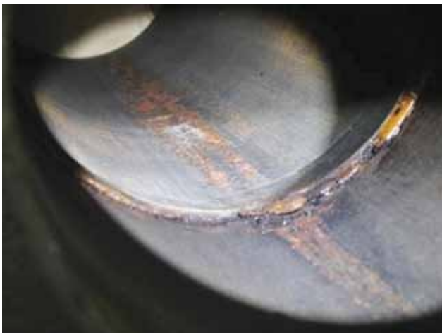
Figura 11. Banda longitudinal de corrosión.
