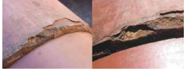
Figura 5. Desprendimiento de coating y corrosión con pérdida de material en el borde de junta del lado 1B.
