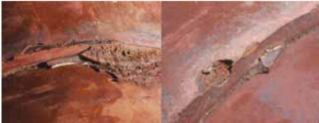
Figura 10. Remanentes de resina epoxi del embonamiento en el borde de junta 2B.
