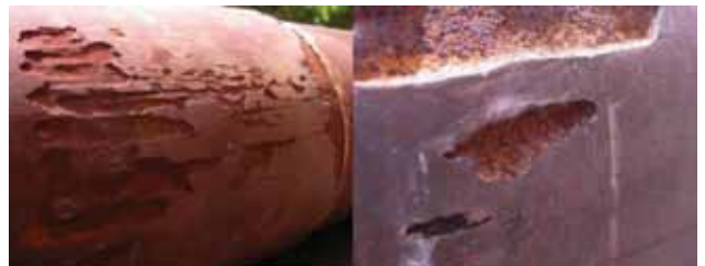
Figura 13. Desprendimiento de coating y corrosión con pérdida de material en el cuerpo de la muestra 3.
