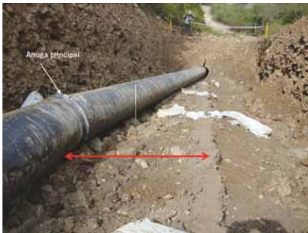
Figura 8. Desplazamiento de la cañería fuera de la cuna en un valor cercano a 1,25 m.
