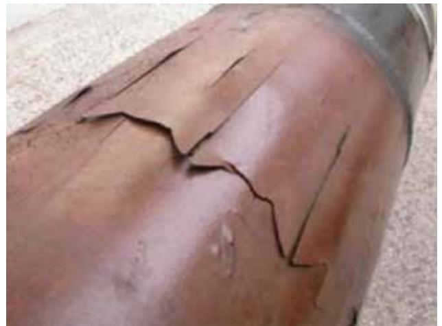
Figura 28. Muestra 2, posensayo. Delaminación del recubrimiento epoxi debido a deformación plástica circunferencial, lado B, similar al de la muestra 1.
