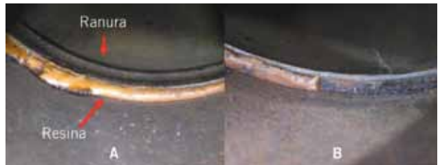
Figura 7. a) Remanentes de resina epoxi en el borde de junta del lado 1A. Detrás, el pliegue de la ranura de almacenamiento de resina. b) Zonas de dicho borde con desprendimiento de resina.
