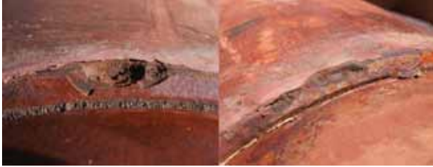
Figura 9. Desprendimiento de coating y corrosión con pérdida de material en el borde de junta 2B.
