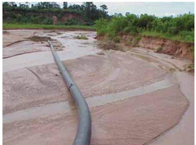
Figura 1. Cruce del Riacho Seco. Exposición del cuello de cisne en margen derecha o sur.
