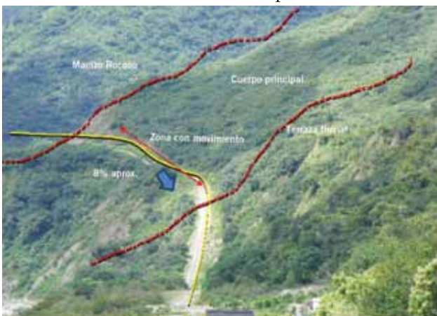
Figura 5. Vista en campo de las dimensiones y geometría del talud.
