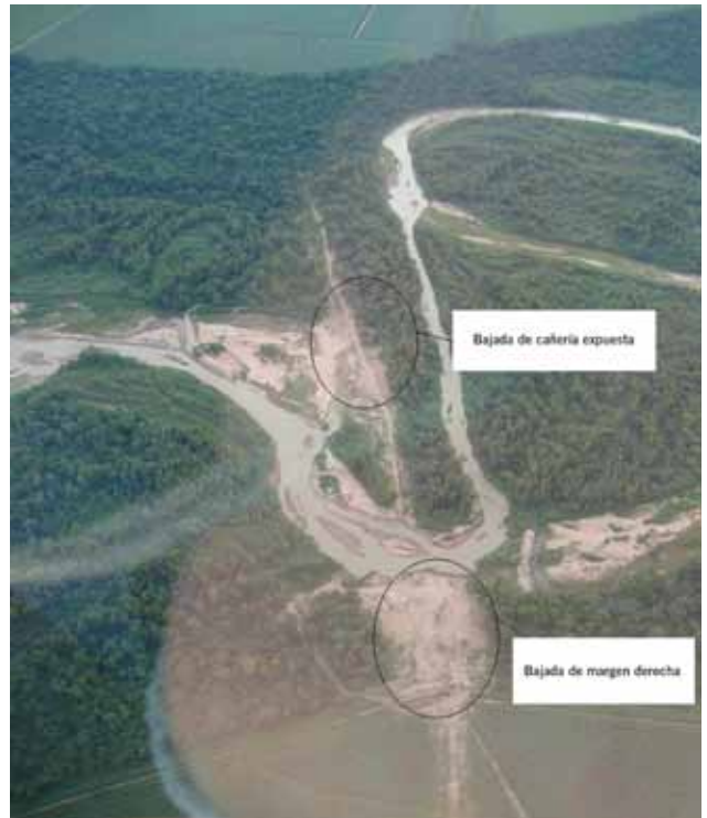
Figura 20. Situación del cruce luego de la bajada de cañería.
