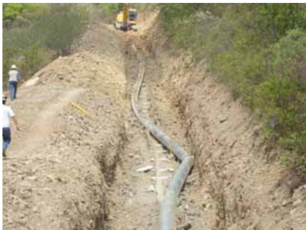
Figura 9. “Serpenteo” de la cañería a medida que se prosigue con la liberación, debido a tensiones acumuladas.
