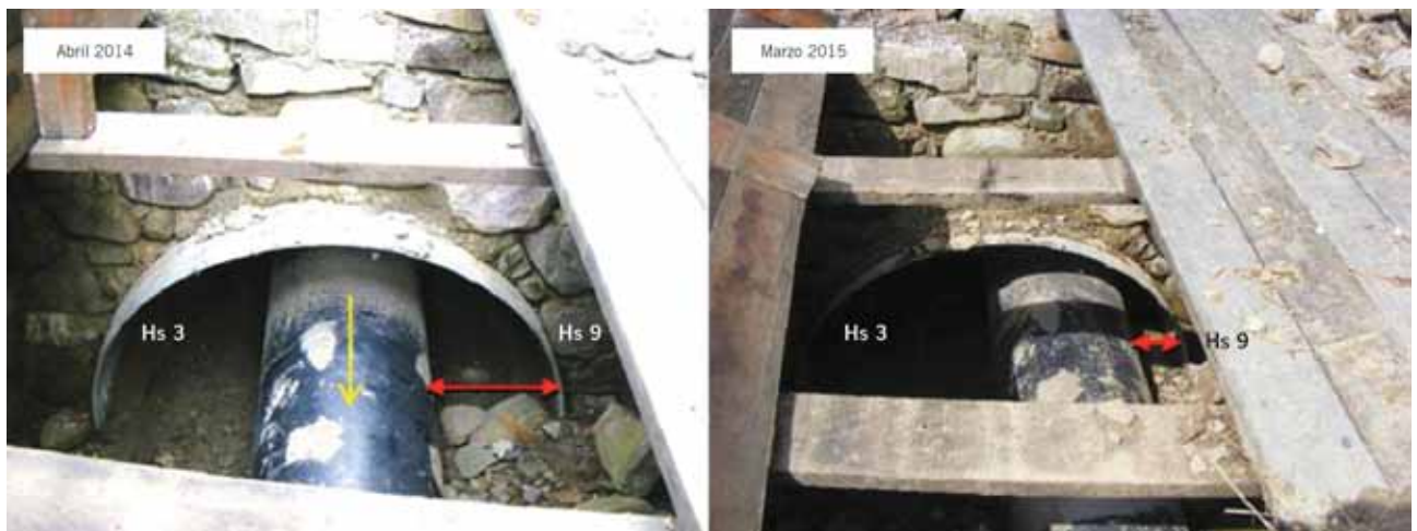
Figura 11. Se observa claramente la reducción del espacio entre el anillo de acero y el caño entre 2014 y 2015 como producto del empuje lateral del terreno.
