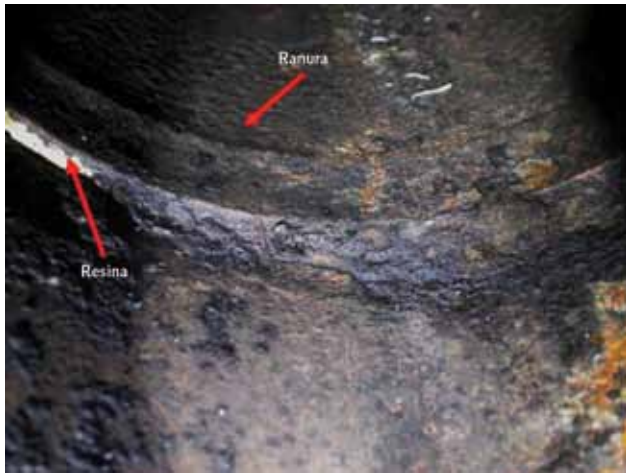
Figura 16. Remanentes de resina epoxi con desprendimiento parcial del excedente y ranura de sello de resina.
