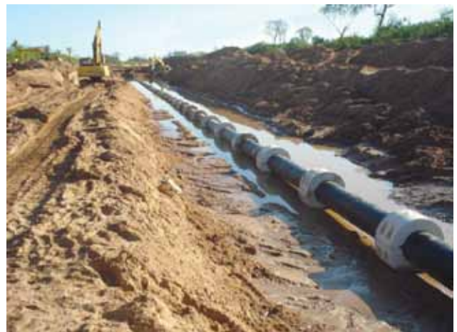
Figura 21. Operación de bajada y posterior contrapesado.
