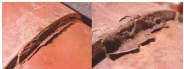
Figura 6. Remanentes de resina epoxi del embonamiento en el borde de junta del lado 1B.
