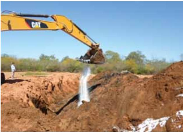
Foto 5. Proceso de mezclado con nutrientes
