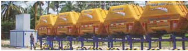
ATS montados sobre plataformas PAD y conectados a la PRP en la estación fija.
