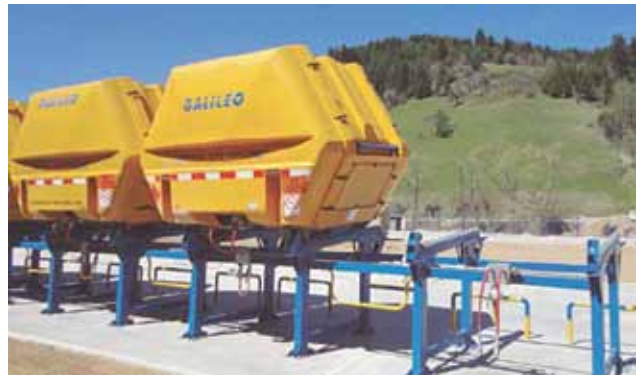
MATs montados sobre plataformas PAC en la estación madre.
