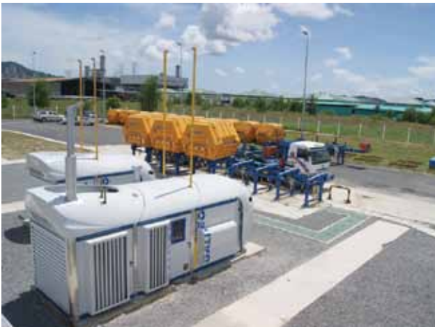
En la estación madre, los compresores cargan los contenedores MAT para su posterior distribución.
