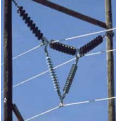
Figuras 8 a y b. Líneas de CA convencional vs CA compacta de 500 kV.
