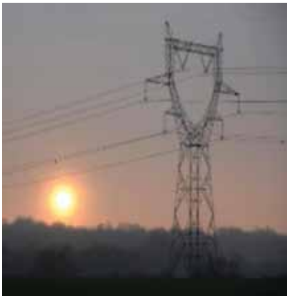
Figuras 10 a y b. Disposición en triángulo de los conductores.
