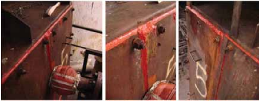
Figura 2. Detalle del sellado de fugas en la zona convectiva de un horno.
