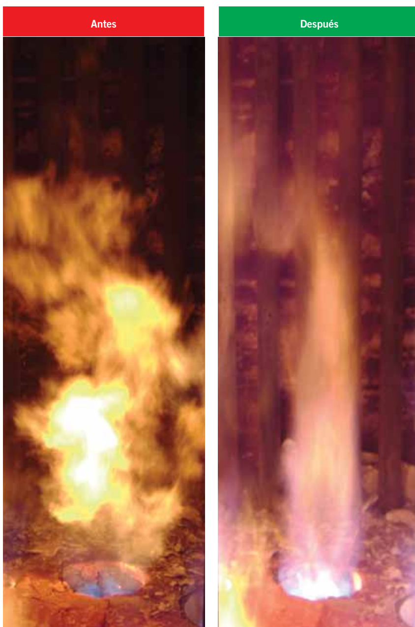
Figura 1. Formato de llama antes y después del correcto mantenimiento de quemadores.
