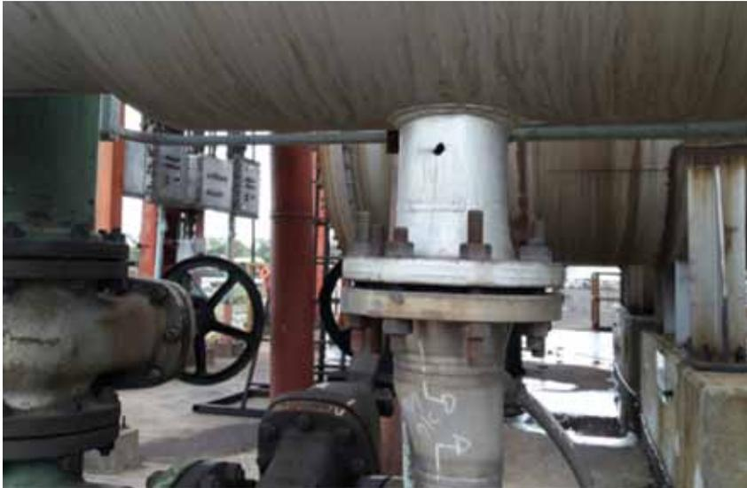
Figura 1. Orificio sobre conexión de salida de condensador.
