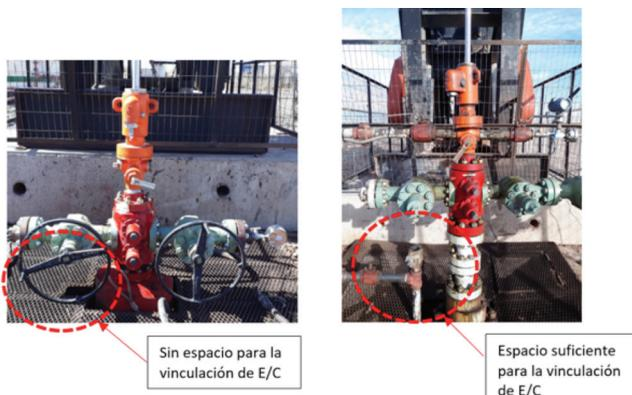
Figura 20. Instalación con carretel espaciador.
