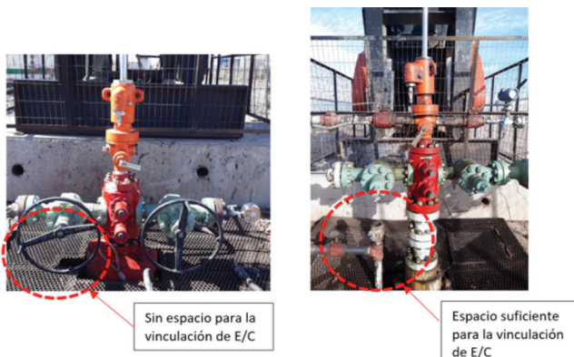
Figura 20. Instalación con carretel espaciador.
