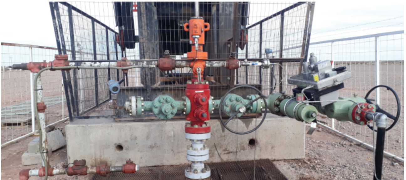
Figura 16. Instalación del conjunto de despresurización en Pzo-5.
