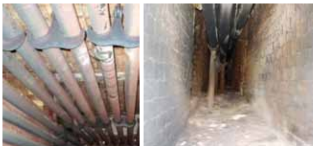
Figura 4 (izq). Anclajes de los serpentines.
