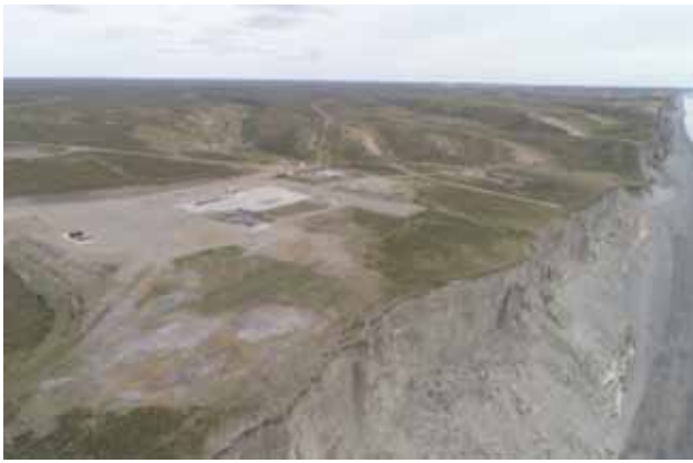
Figura 1. Imagen aérea del acantilado, relevamiento con dron, enero 2020.
