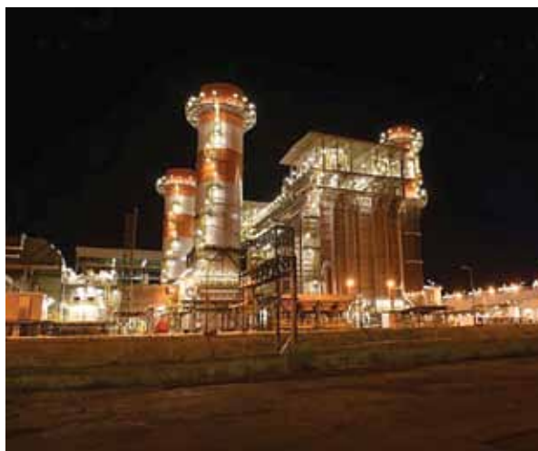
Complejo Parnaíba, el primero de los proyectos R2W de Eneva. La central Jaguaritica II será el segundo gracias al GNL producido por los Cryobox en Campo de Azulão.
