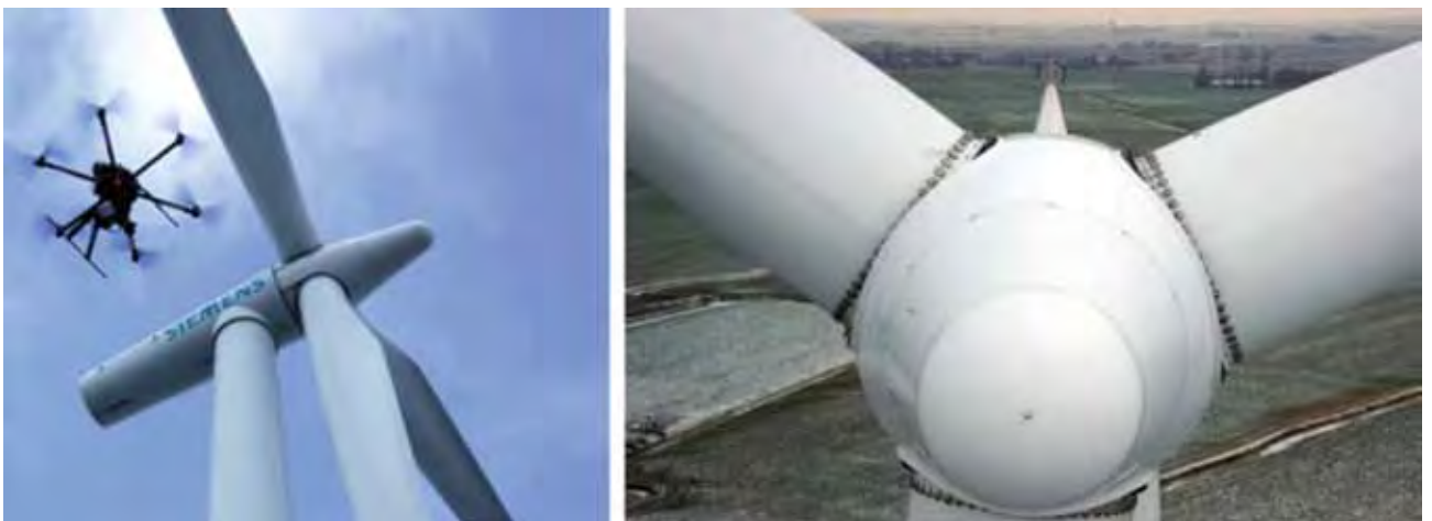
Figura 14. Trabajo de inspección con un hexacóptero y cámara digital de 24 megapíxeles calibrada a 90 m sobre el terreno.
