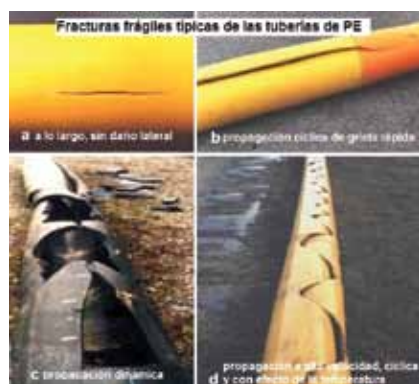
Figura 2. Fracturas frágiles típicas de tuberías de polietileno: a) a largo término, sin daño lateral; b) propagación crítica de grieta, rápida; grieta dinámica con de material, espesor de pared grueso; d) grieta "running crack", propagación a muy alta velocidad, comportamiento cíclico y frágil con efecto de latemperatura. Extraído de Reliability index computation for HDPE pipe using critical stress intensity factor . Kamel CHAOUI a, Latifa ALIMI a,b, Salaheddine AZZOUC. 23ème Congrès Français de Mécanique Lille, 28 Août au 1er Septembre 2017.
