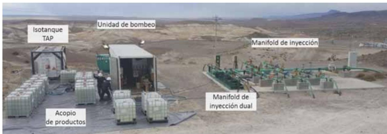
Figura 16. Operación de inyección. Equipos instalados y conectados al manifold.
