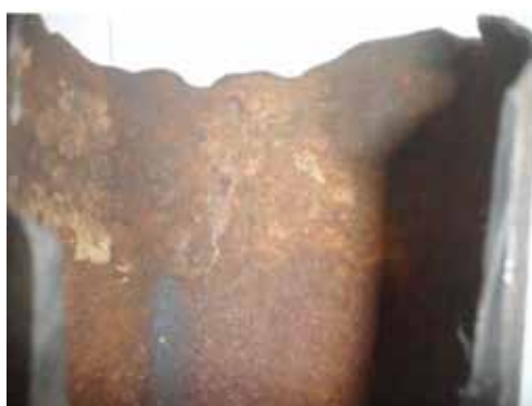
Figura 6. Zona erosionada del lado interno del tubing .
